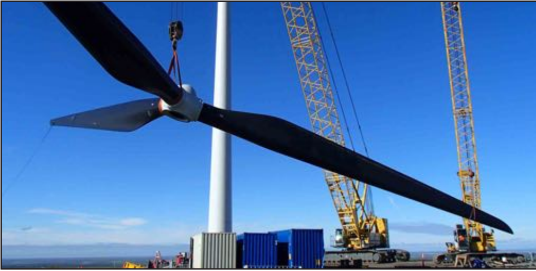
Rotor Blade Install, AVEC Saint Mary's and Bethel Wind Sites, STG, Inc.
